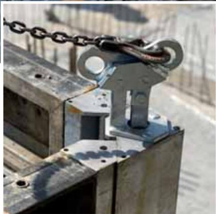
*Eine Demontage der Innenschalung z. B. bei Aufzugschächten oder Treppenhauskernen ist, wenn NOEtop Ausschalecken eingesetzt werden, nicht mehr notwendig.*
