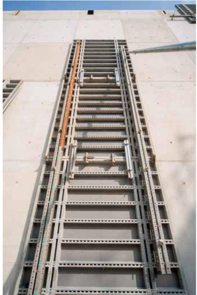
Schön sichtbar das durchgängige Schaltable-Raster mit stehend und liegend eingesetzten Schaltablen der NOEtop Wandschalung.
