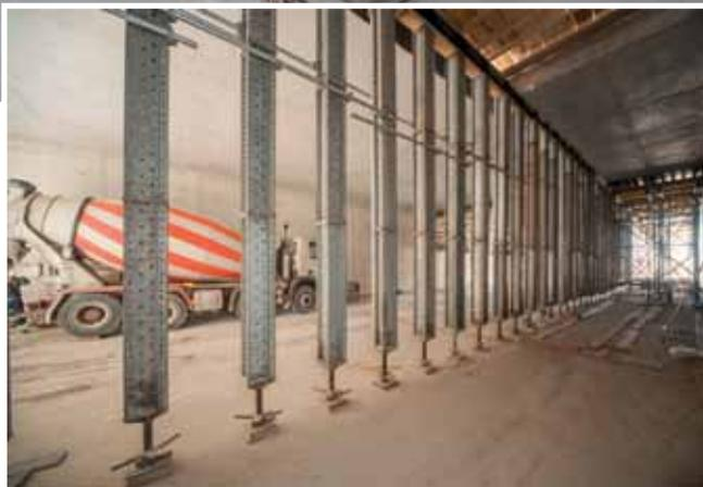
Die Rückunterstützung erfolgte mit NOE LS 200 Schwerlaststützen.
