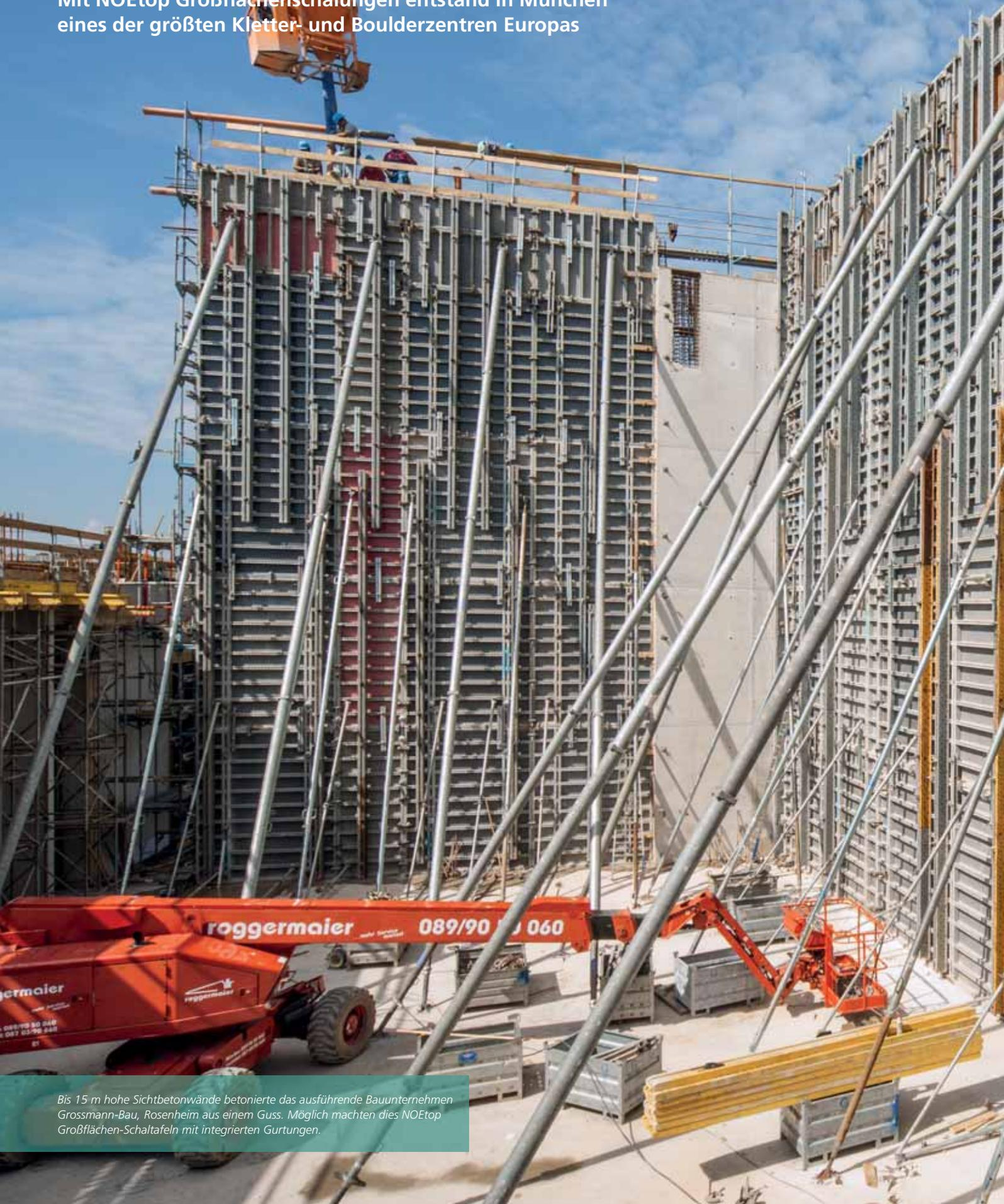
Bis 15 m hohe Sichtbetonwände betonierte das ausführende Bauunternehmen Grossmann-Bau, Rosenheim aus einem Guss. Möglich machten dies NOEtop Großflächen-Schaltafeln mit integrierten Gurtungen.
