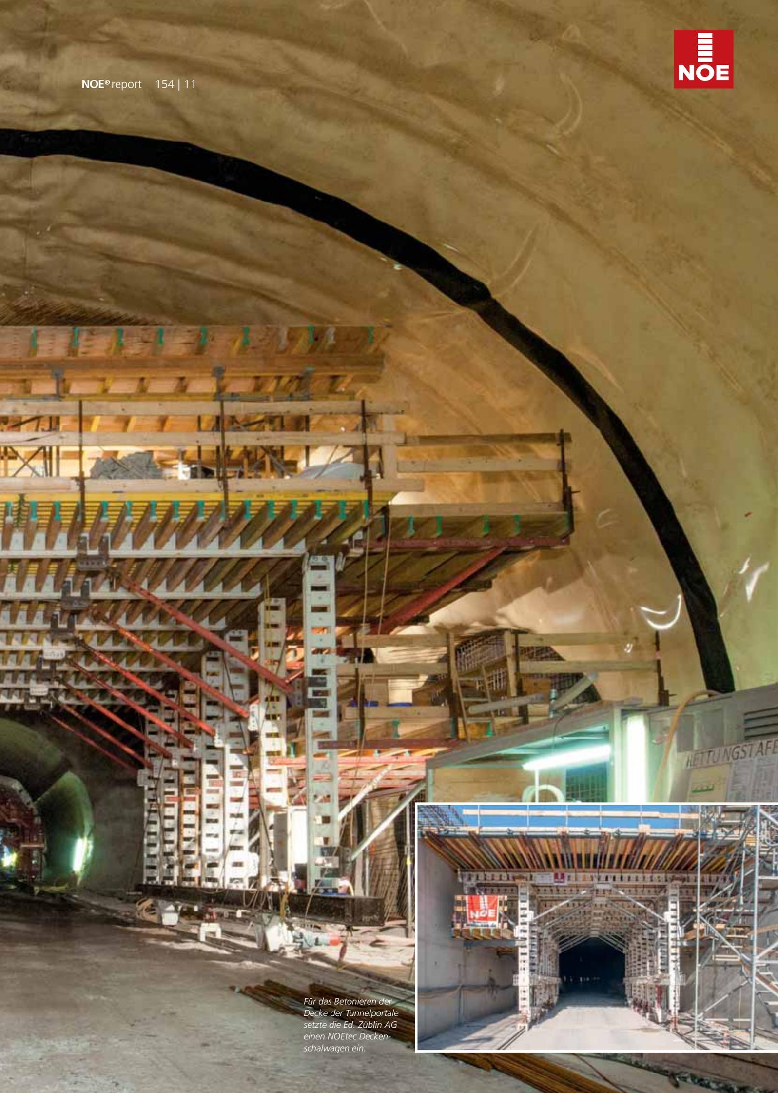
*Für das Betonieren der Decke der Tunnelportale setzte die Ed. Züblin AG einen NOEtec Deckenschalwagen ein.*
