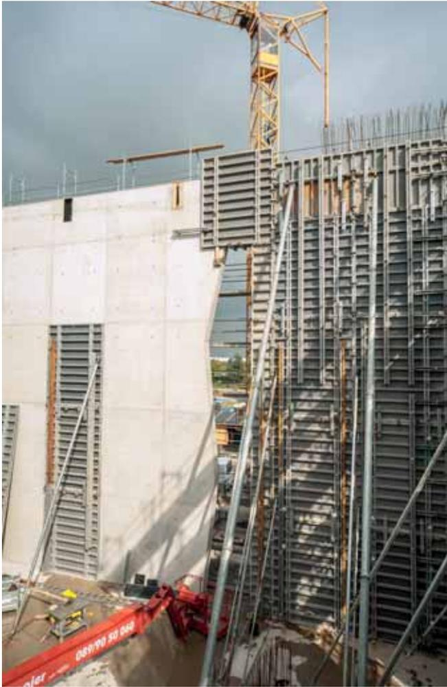
15 m hohe Sichtbetonwände in einem Guss betoniert.
