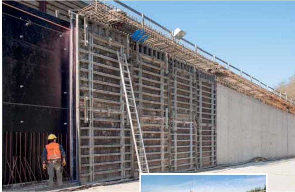
Mit NOEtop Großflächenschalttafeln wurden die Wände der Tunnelportale betoniert. Innerhalb der Gurtungen ist die Lage der Spannstellen frei wählbar.
