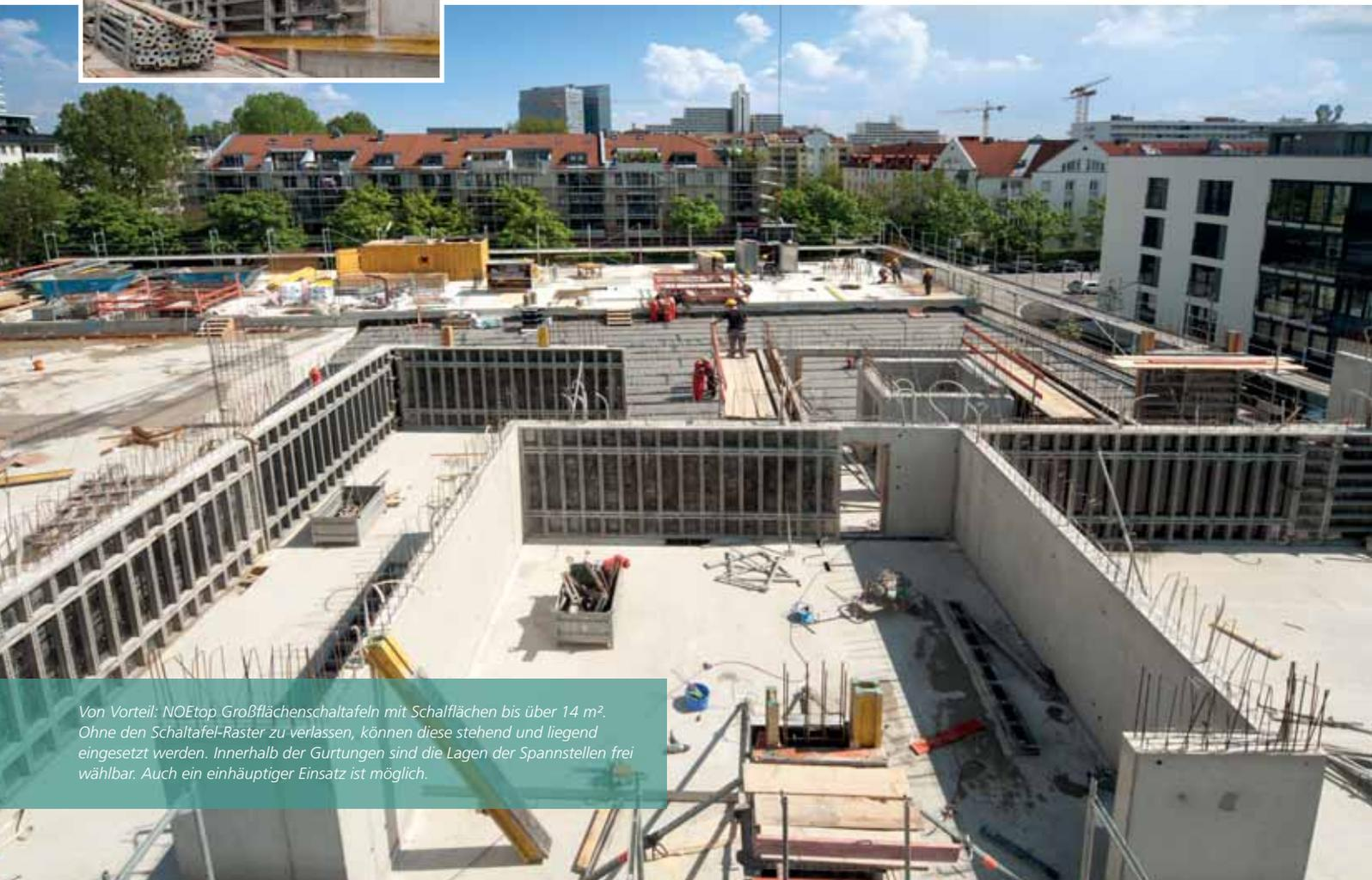
Von Vorteil: NOEtop Großflächenschalttafeln mit Schallflächen bis über 14 m<sup>2</sup>. Ohne den Schalttafel-Raster zu verlassen, können diese stehend und liegend eingesetzt werden. Innerhalb der Gurtungen sind die Lagen der Spannstellen frei wählbar. Auch ein einhäuptiger Einsatz ist möglich.
